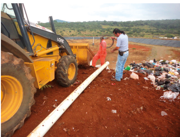
Cobertura y compactación de residuos sólidos y colocación de tubos de biogás en el relleno sanitario intermunicipal
