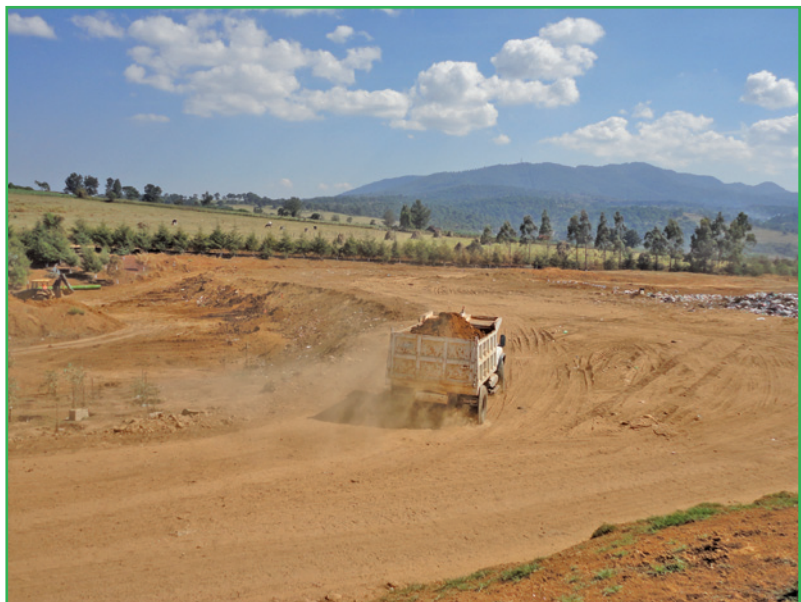
Relleno sanitario intermunicipal del SIMAR Sureste , en diciembre de 2010.
