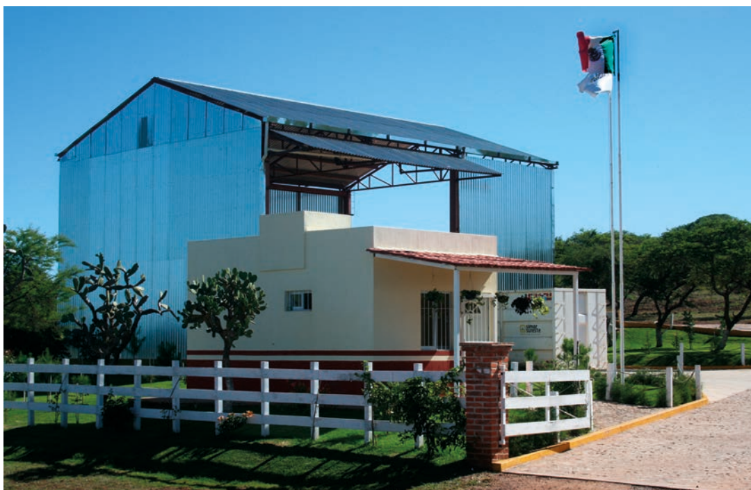
Estación de Transferencia Intermunicipal de Residuos
