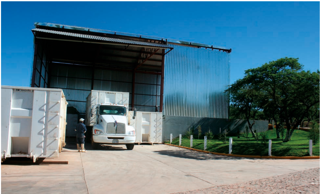
Estación Intermunicipal de Transferencia de Residuos Suroeste
