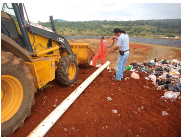
Cobertura y compactación de residuos sólidos y colocación de tubos de biogás en el relleno sanitario intermunicipal
