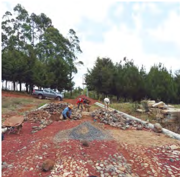
Obras de reparación de muros con hundimiento y filtraciones en techos que presentaban daños por humedad, así como construcción de banqueta y empedrado de 640 metros en el Centro Intermunicipal de Educación Cívico Ambiental. 2017.
