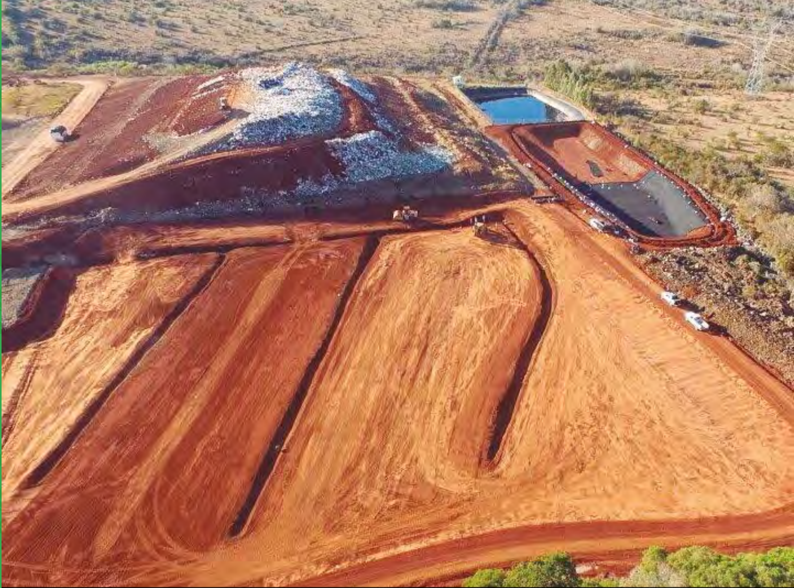
Obras de ampliación celda II relleno sanitario intermunicipal SIMAR Sureste, y trabajos de conformación de taludes celda I para su cierre y abandono de conformidad con los establecidos por la normatividad ambiental vigente, 2018.
